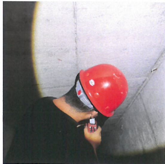
图 3.2.2.1-6 排水方涵现状照片
