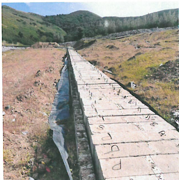
图1 排水设施外观照
