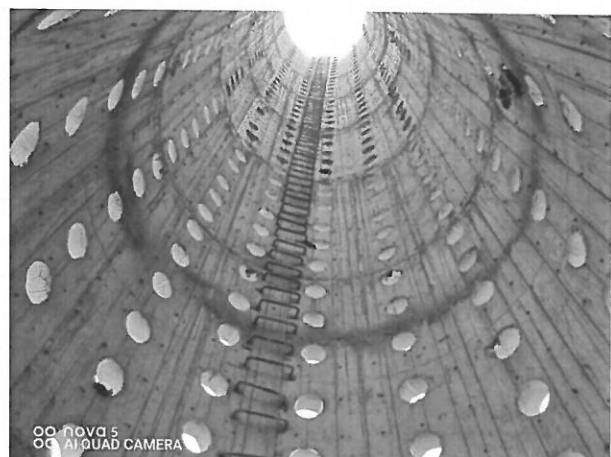
图 3.2.2.1-6 排水井现状照片
