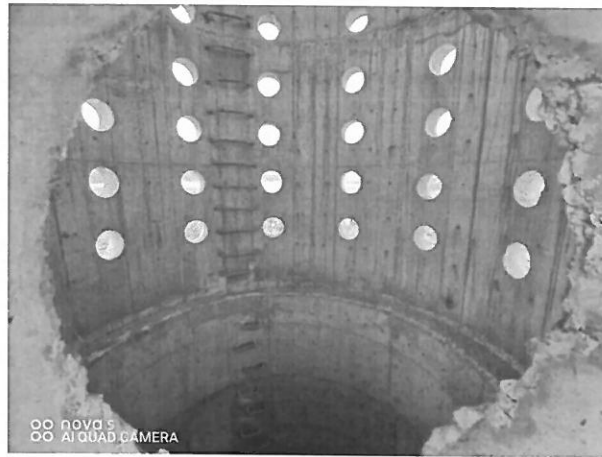
图 3.2.2.1-5 排水井现状照片
