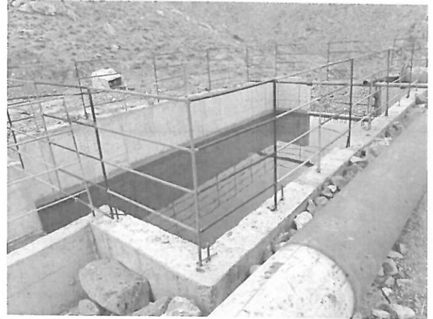
图 3.2.2.1-12 排水管道现状照片
