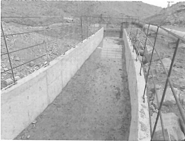
图 3.2.2.1-11 排水管道现状照片
