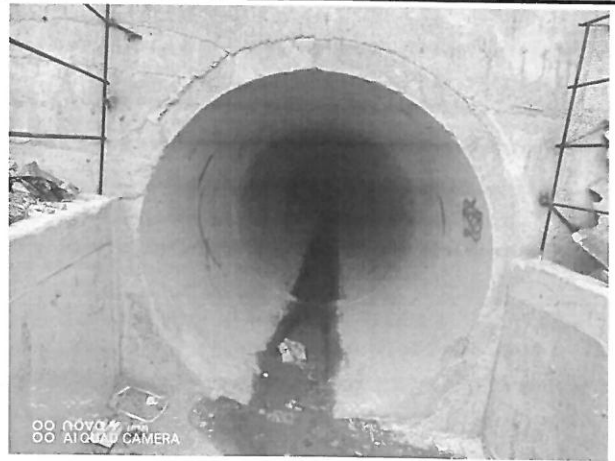
图 4 排水涵管外观照
