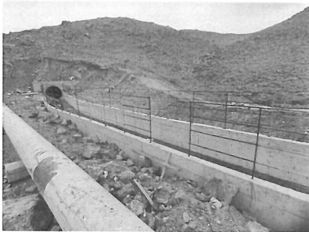
图 5 导流明渠外观照
