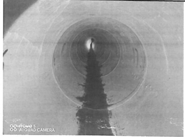
图 3.2.2.1-10 排水管道现状照片
