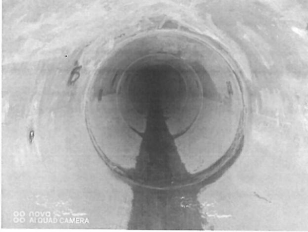
图 3.2.2.1-9 排水管道现状照片
