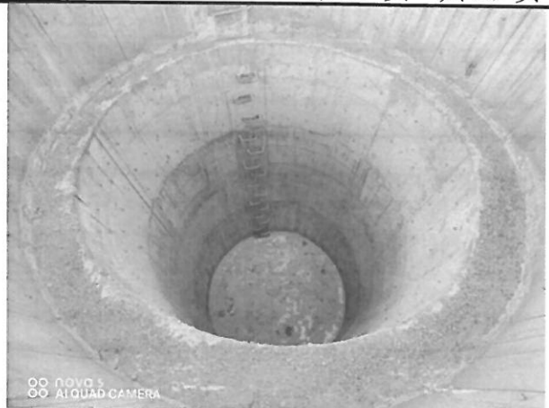
图 3.2.2.1-4 排水井现状照片
