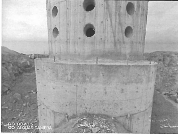
图 3.2.2.1-3 排水井现状照片
