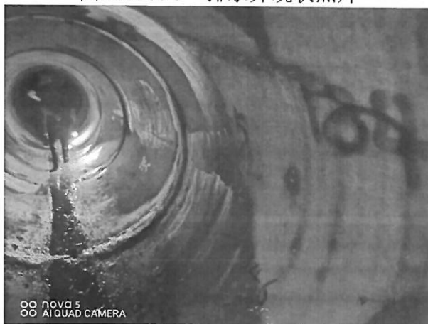
图 3.2.2.1-7 排水管道现状照片
