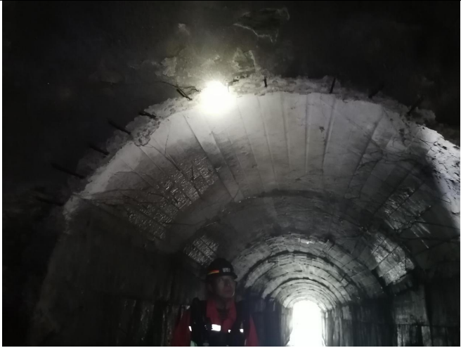
图 3.2.2.2-1 隧洞洞口拱顶混凝土衬砌
