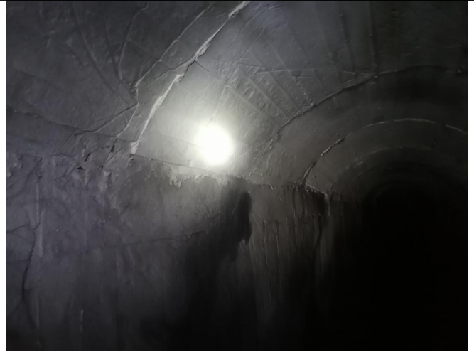
图 3.2.2.2-2 隧洞洞口拱顶混凝土衬砌
